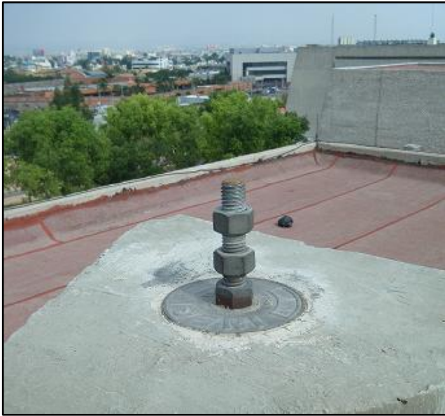
Tuercas para fijar la antena GNSS
