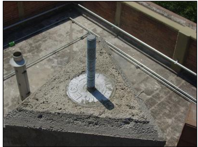
Colocación del Tornillo de 5/8 "
